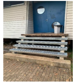
Neue Treppe zum Lieferanteneingang
