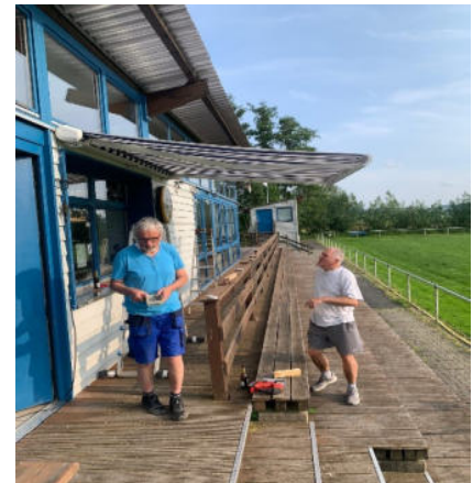
Unsere fleißige MET montiert die neue Markise
